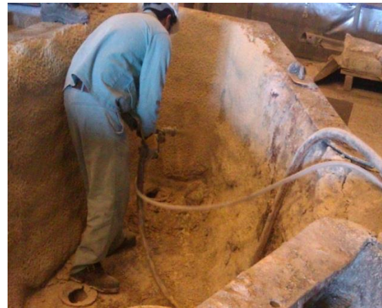
شکل ۴: ایستگاه کاری پلاسترزنی - بعد از مداخله
