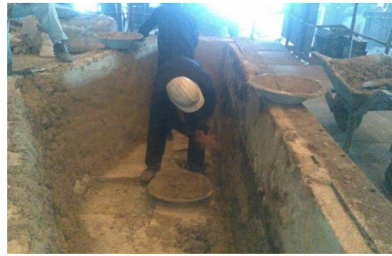
شکل ۲: ایستگاه پلاسترزنی تاندیش- قبل از مداخله
