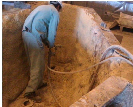
شکل ۴: ایستگاه کاری پلاسترزنی - بعد از مداخله
