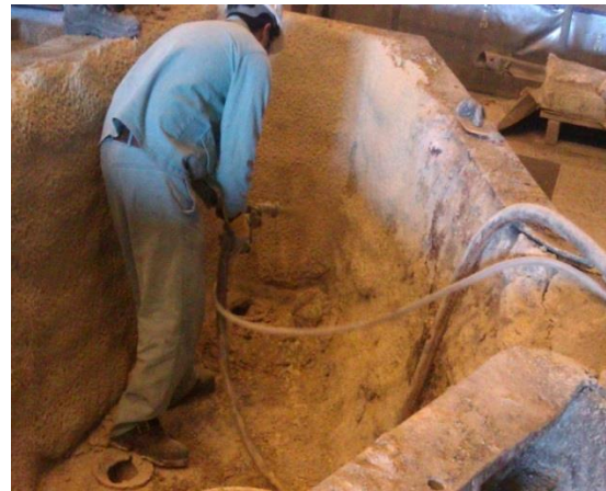
شکل ۴: ایستگاه کاری پلاسترزنی - بعد از مداخله
