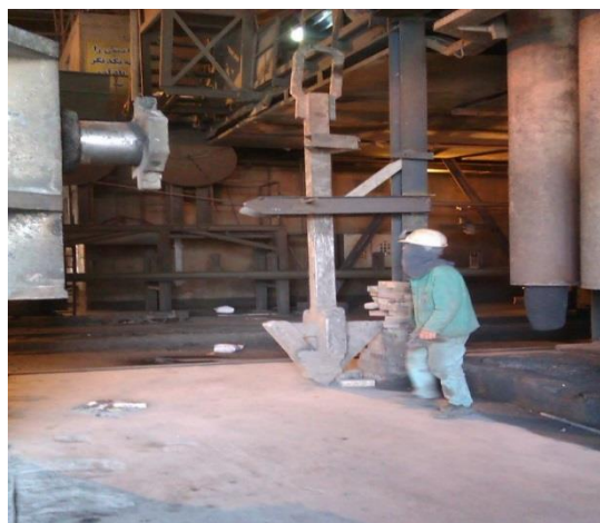
شکل ۳: ایستگاه کاری اسلایدگیت- بعد از مداخله
