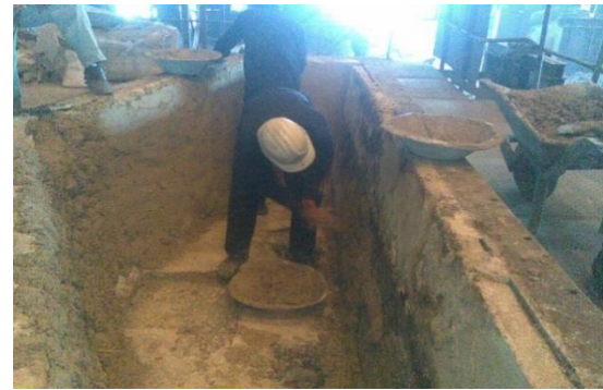
شکل ۲: ایستگاه پلاسترزنی تاندیش- قبل از مداخله
