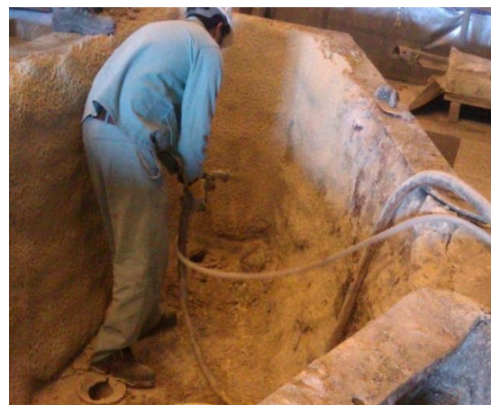
شکل ۴: ایستگاه کاری پلاسترزنی - بعد از مداخله
