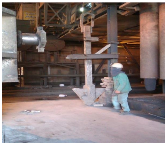
شکل ۳: ایستگاه کاری اسلایدگیت- بعد از مداخله
