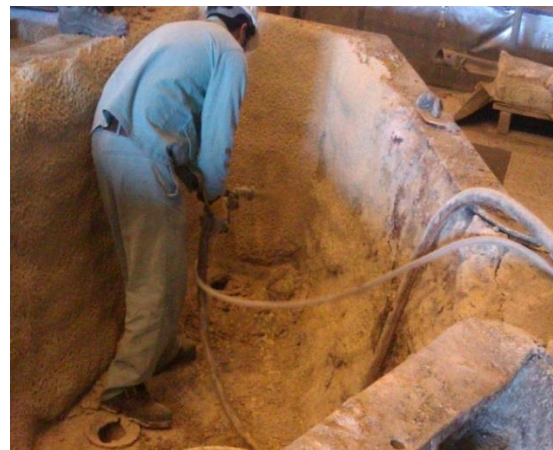
شکل ۴: ایستگاه کاری پلاسترزنی - بعد از مداخله
