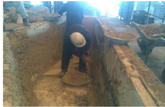
شکل ۲: ایستگاه پلاسترزنی تاندیش- قبل از مداخله
