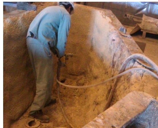
شکل ۴: ایستگاه کاری پلاسترزنی - بعد از مداخله
